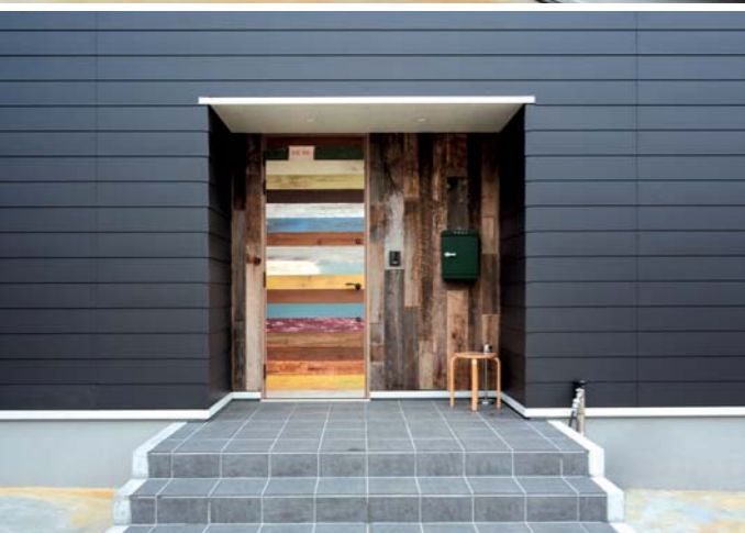
上/2階にあるリビングスペースは天井にレッドシダーを張り、正面に掃き出し窓、TVボードの左右に縦長窓を設けている 中/建物背面の外壁は木。深めの庇の下、1階と2階の両方にデッキが伸びる 下/ビンテージ仕上げの板を組み合わせた玄関周り。板のエイジング加工は地元の塗装屋に依頼した
